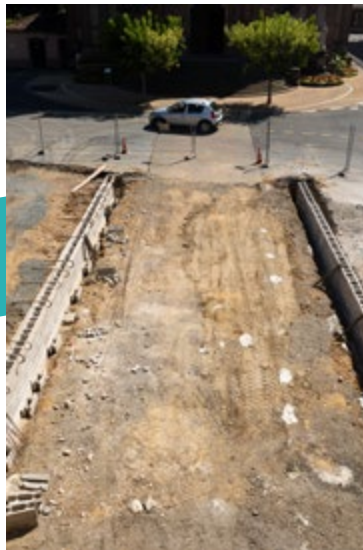
Création d'un rampe d'accès piétonne sur le parvis (accessible PMR)
