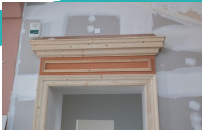
réalisation de menuiseries intérieures par les équipes des services techniques
