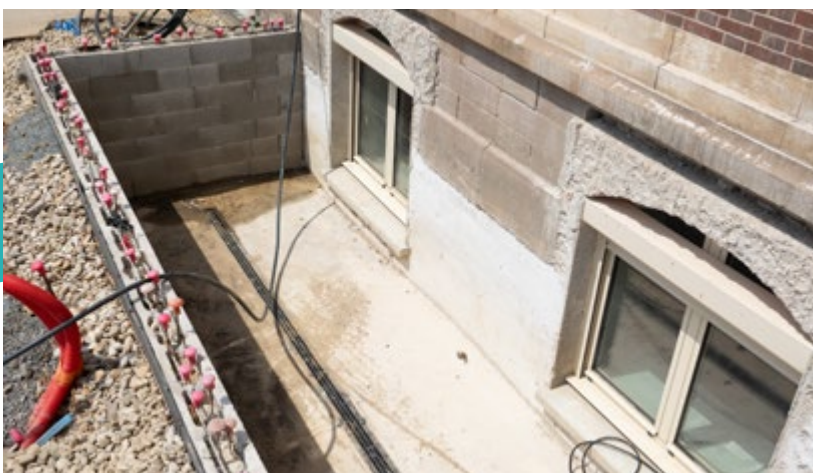
construction d'une cours anglaise côté parvis.
